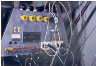
Abb.2.56: 38 l-Behälter: Nadelventile für die Brenngaszuführung mit Kabelverbindungen
